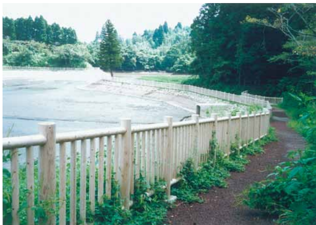
A-1 木製安全柵 L1500×H1300 (1スパン) 杉・ペンタキュアニュー BM防腐注入 (洞庭湖・一の宮町)
