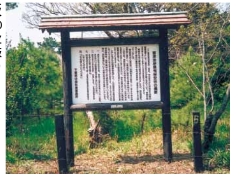
A-46 屋根つき看板 H2050×L2490 杉焼丸太・屋根杉皮 表示板アルミ複合板 (富津岬・富津市)
