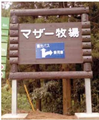
A-43 案内看板 H4500×H3400 杉・タナリス防腐注入 表面保護塗料塗布 (テーマパーク・富津市)
